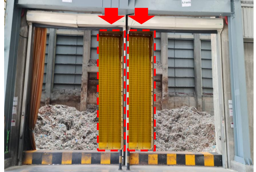
รูปตัวอย่างแผ่นม่านประตูด้านในของประตูอัตโนมัติ
